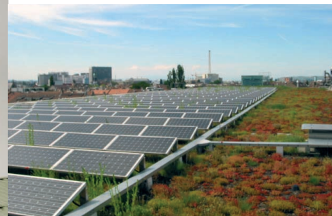
Telhado vivo de Sedum com painéis fotovoltaicos, Messehalle, Basileia-Cidade, Suíça.
